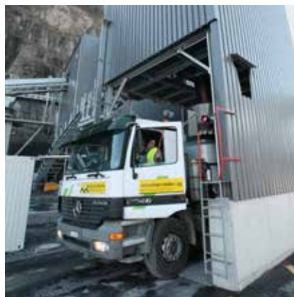
Vollautomatische Verladeanlage für die zeitsparende Selbstbedienung.
